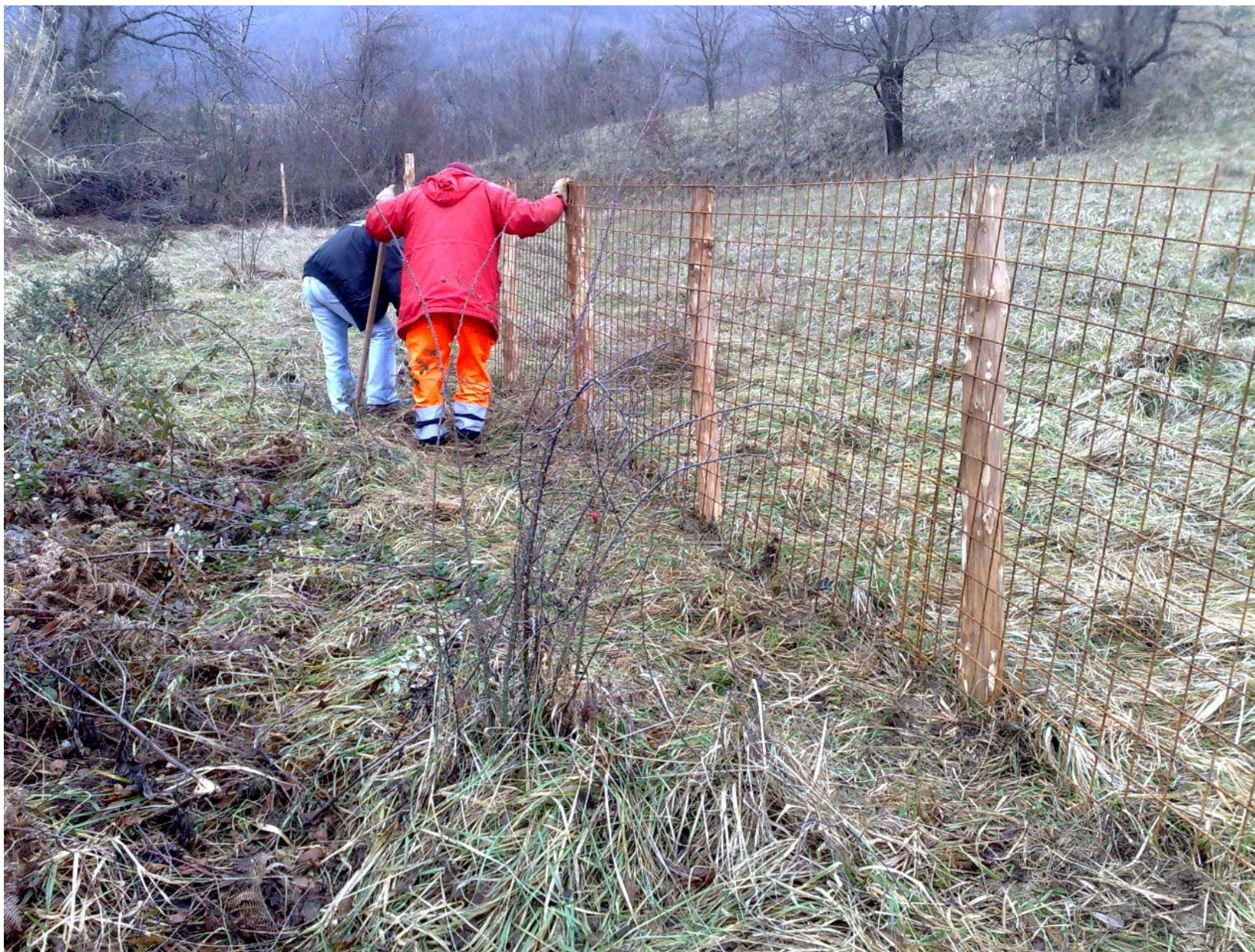
Operai che montano la recinzione
