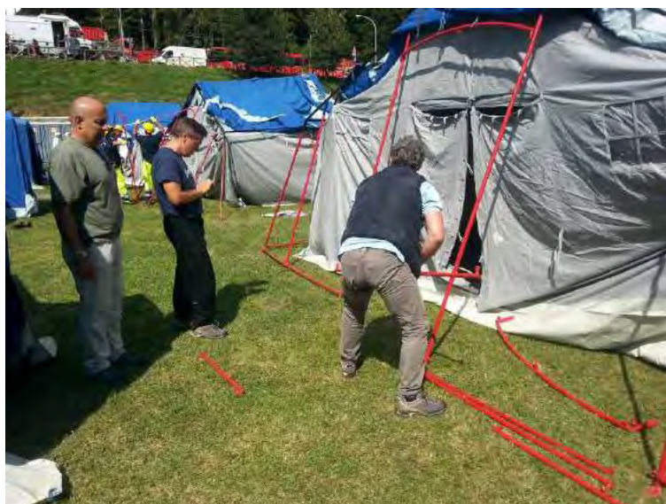
Montaggio del campo sfollati ad Arquata del Tronto (AP), 25/08/16
