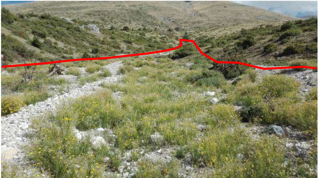
Figura 96 - L'area del ghiaione lungo la SP 86, come si presentava nel 2017 prima dell'intervento.
