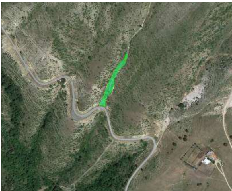
Figura 95 - Mappa dell'area del ghiaione lungo la SP 86, oggetto di intervento nel 2017
