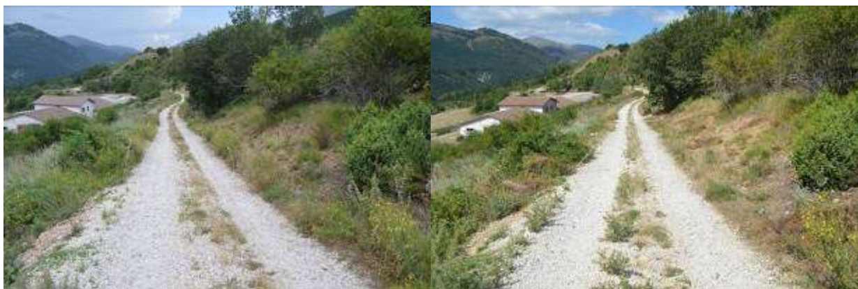
Figura 109 – Vialetto di ingresso all'azienda prima (sx) e dopo (dx) l'intervento
