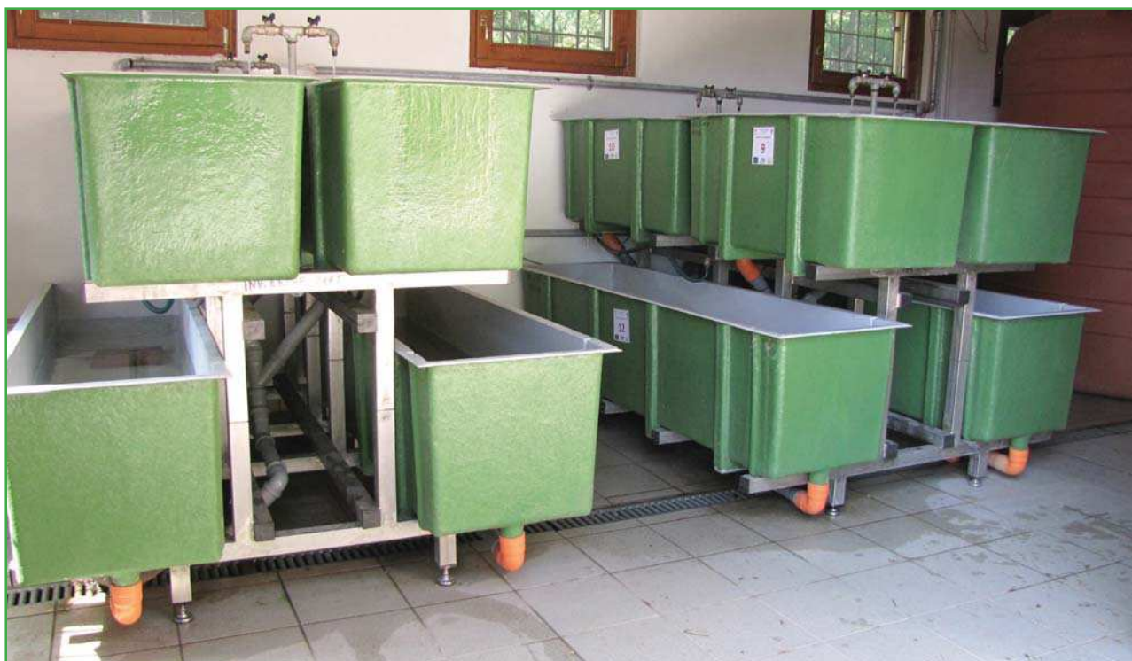
FIGURA 19. Vasche montate sul castello in acciaio.
