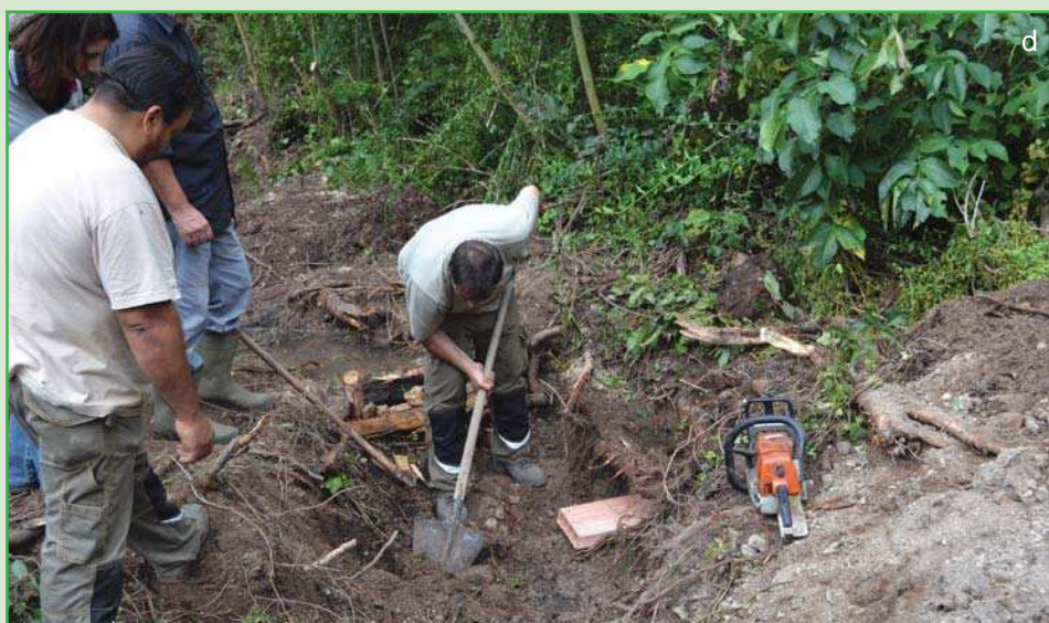
FIGURA 16. Interventi di riqualicazione ambientale per migliorare l'habitat idoneo alla vita di A. pallipes . (a) passaggio ligneo nel SIC IT2070021 Valvestino; (b) consolidamento delle sponde e recinto elettrico nel SIC IT2060016 Valpredina; (c) restoration ecology nel SIC IT2010002 Monte Legnone e Chiusarella; (d) cantiere didattico AIPIN per la riqualicazione nel SIC IT7110098 Sorgenti e primo tratto del fiume Tirino.
